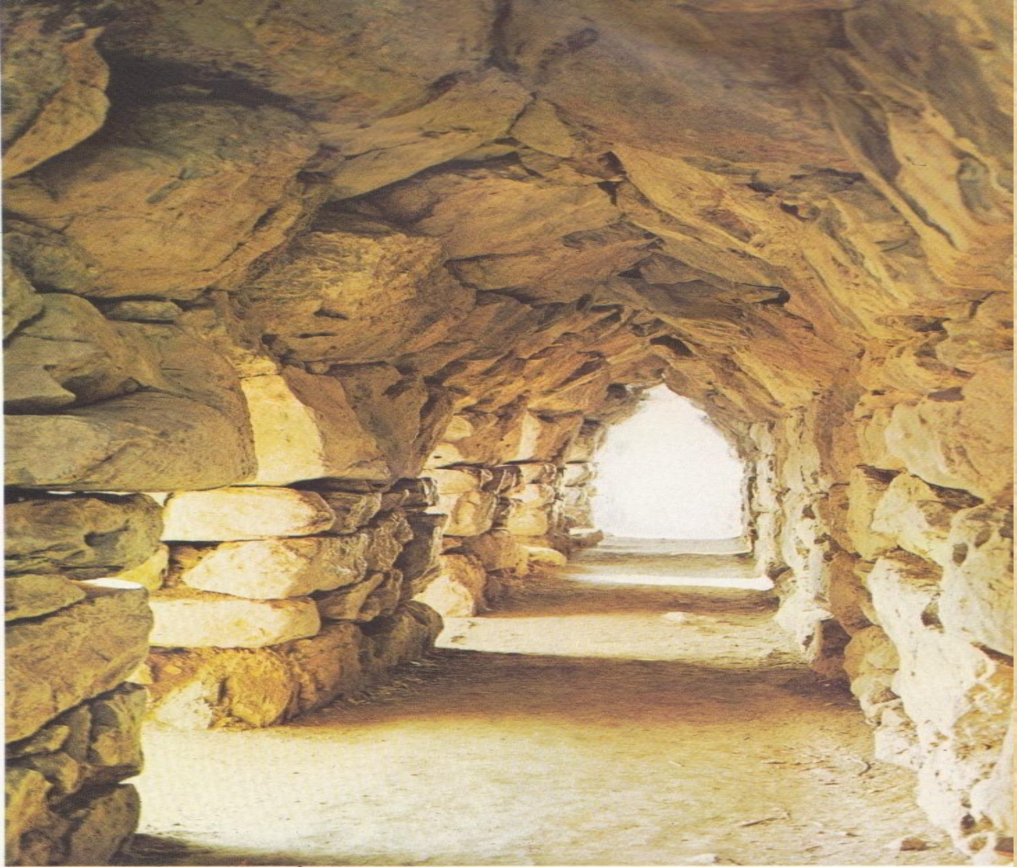
“Ένας από τους εσωτερικούς διαδρόμους (σύριγξ) στο κυκλώπειο τείχος της Τίρυνθος. Οι έντυπωσιακές αυτές διαβάσεις έχουν πλάτος 1,65 και ύψος των καθέτων πλευρών 1,75 μ. Στο επάνω τμήμα τα ΧΡΗΣΤΟΔΟΥΛΑΚΗΣ ΧΡΗΣΤΟΣ ΔΙΑΔΟΛΟΣ ΕΣΩΤΕΡΙΚΟ ΣΥΣΤΗΜΑ, κλίνουν προς το εσωτερικό, στενεύουν και σχηματίζουν μια δξενκόρνηφη καμάρα ΕΥΜΝΑΣΙΟ ΓΑΖΟΥ. Η σύριγγες εξυπηρετούσαν τις αποθήκες της ακροπόλεως.
