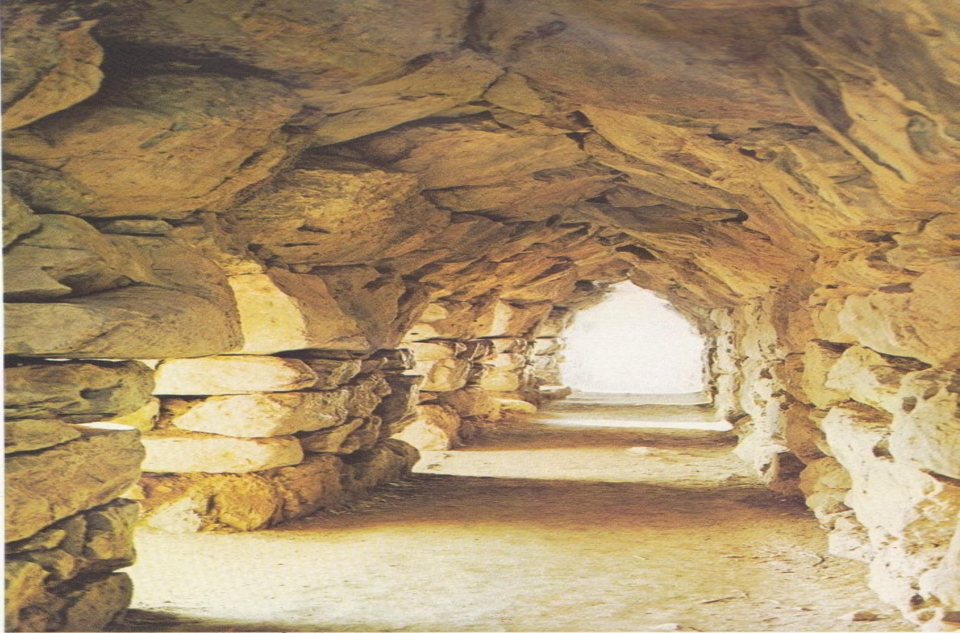
“Ένας από τους εσωτερικούς διαδρόμους (σδροιγξ) στο κυκλώ- πειο τείχος της Τίρυνθος. Οι έντυπωσιακές αυτές διαβάσεις έχουν πλάτος 1,65 και ύψος των καθέτων πλευρών 1,75 μ. Στο επάνω τμήμα τα τοιχία ΧΡΗΣΤΟΣ ΦΙΛΑΘΕΟΣ τὸ ἀπλὸ ἐκφο- ρικὸ σύστημα, κλίνουν πρὸς τὸ ἐσωτερικόν, στενεύουν καὶ σχη- ματίζουν μιὰ δὲνκρόρυφη καμάρα ΓΥΜΝΑΣΙΟΝ ΤΑΙΩΝ τριγγες ἐξυπηρετοῦσαν τις ἀποθήκες τῆς ἀκροπόλεως.
